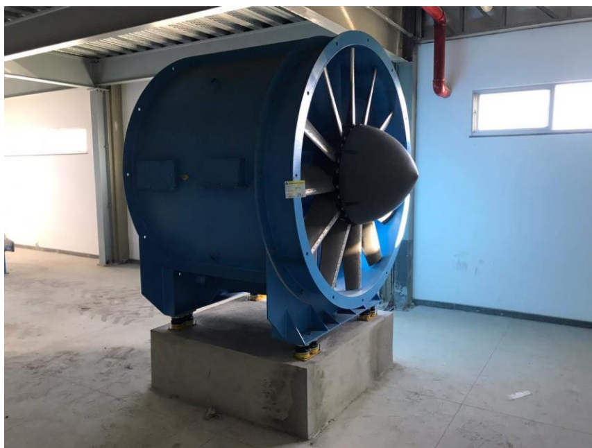
Figura 7 – Sistema de ventilação utilizado no túnel de vento do ISI-ER.
