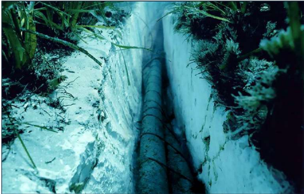
Figura 3.2: Trincheira com cabo
