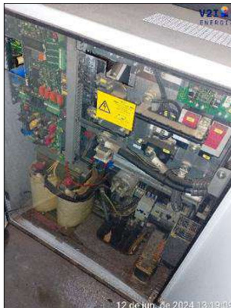
FIGURA 3 - GABINETE DO REOSTATO DE EXCITAÇÃO ABERTO
